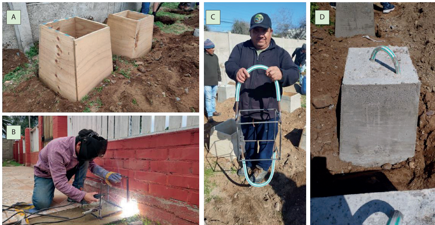
Figura 6. Confección de sistemas de fondeo, donde se muestran los moldes para la estructura (A), confección de armazón para soporte interno del fondeo (B), armazón más orejas para atar los fondeos a la línea madre y al tren de fondeos (C) y fondeo al término de la confección (D).
