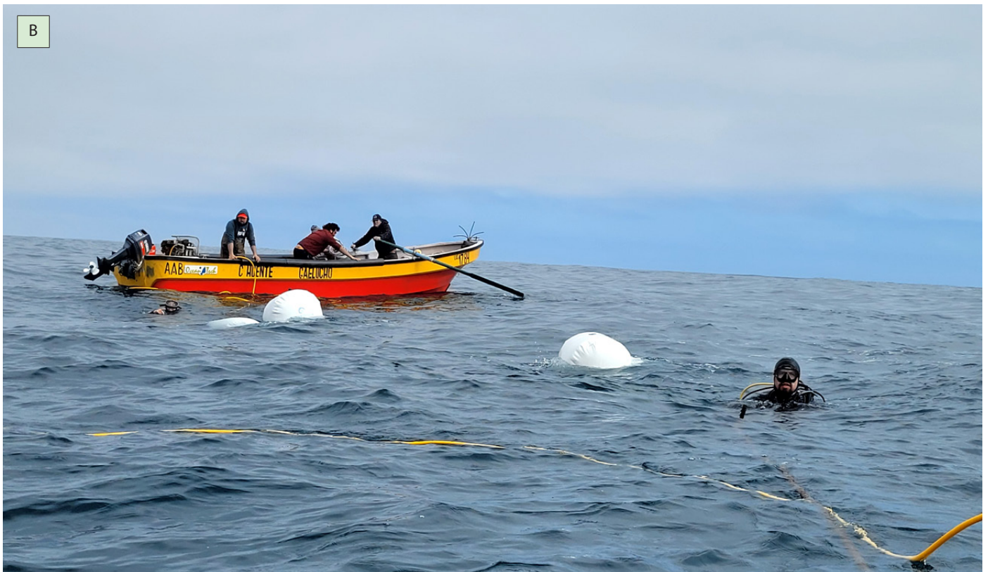
Figura 15. Detalle de maniobra de tensado empleando globos de reflote donde se muestra, (A) tensado de línea desde el fondo y (B) remolque de fondeos con globos a nivel de superficie.
