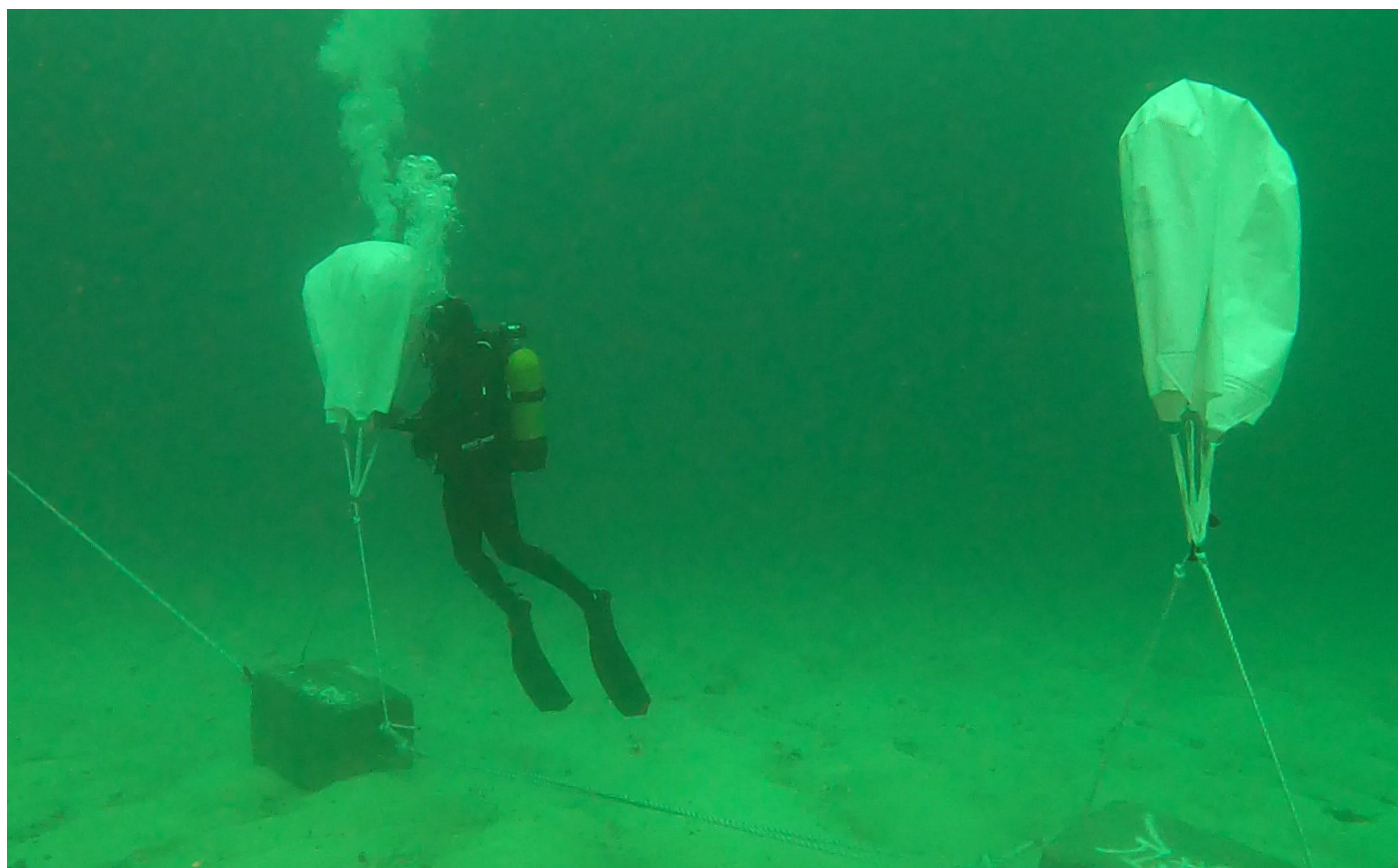
Figura 14. Detalle de maniobra de tensado empleando globos de reflote.
