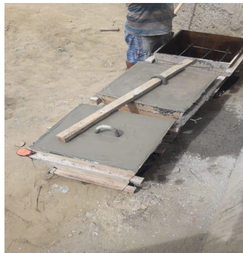
Figura 33: Muertos listos para comenzar a secarse para su utilización.
