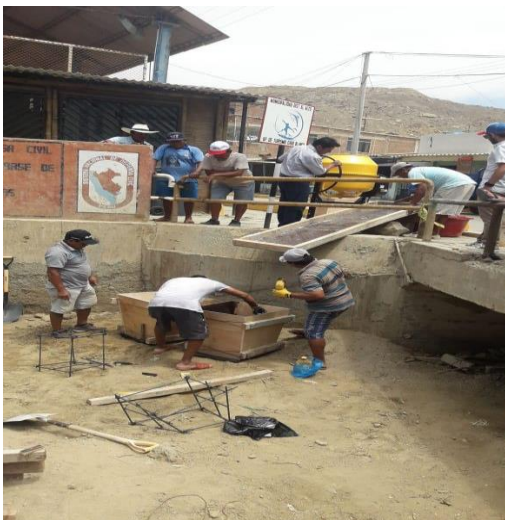
Figura 32: Relleno de moldes de muertos de fondeo.
