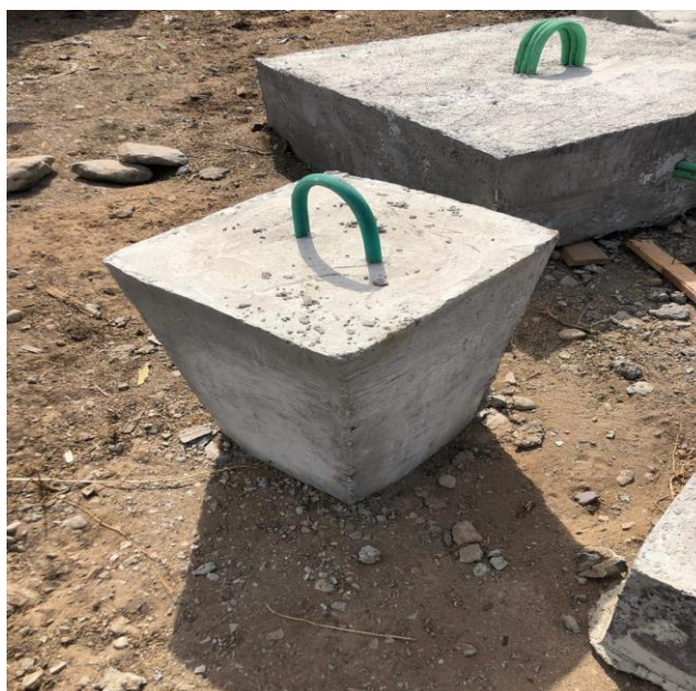
Figura 09: Fondeo de concreto 250 kg.
