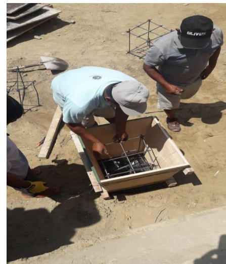
Figura 31: Estructura metálica para soporte del muerto.
