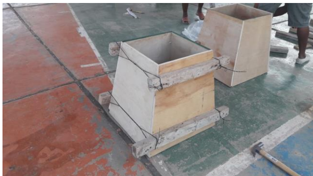
Figura 27. Molde para la confección del muerto de 250 kg: Fabricado en madera y protegido por trozos de madera que evitan que este se reviente mientras es llenado con la mezcla o al momento de comenzar a fraguar.
