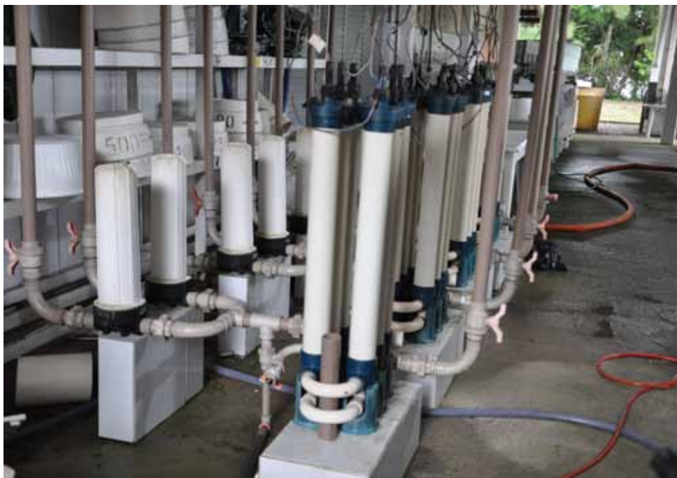
Figura 1. Sistema de tratamento de água com filtros de retenção de partículas e esterilização com radiação ultravioleta (UV)
