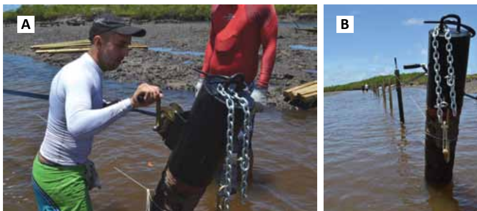
Figura 8. Poste-âncora do sistema de longline ajustável para o cultivo de ostras: (A) Utilização de uma catraca para esticar o cabo; (B) Poste âncora e estacas de sustentação do cabo plástico
