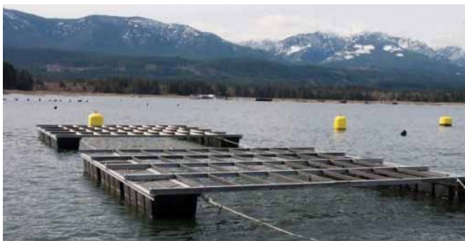
Figura 16. Balsas para cultivo de ostras construídas com perfis de aço e flutuadores de PEAD Foto: Brian Kingzett
