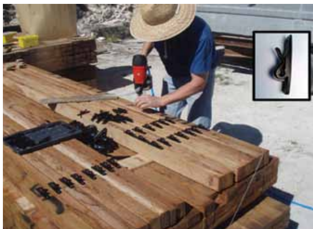
Figura 12. Instalação dos grampos elevadores de cabo nas estacas de madeira. No destaque, detalhe do grampo elevador Foto: BST Oyster Supplies
