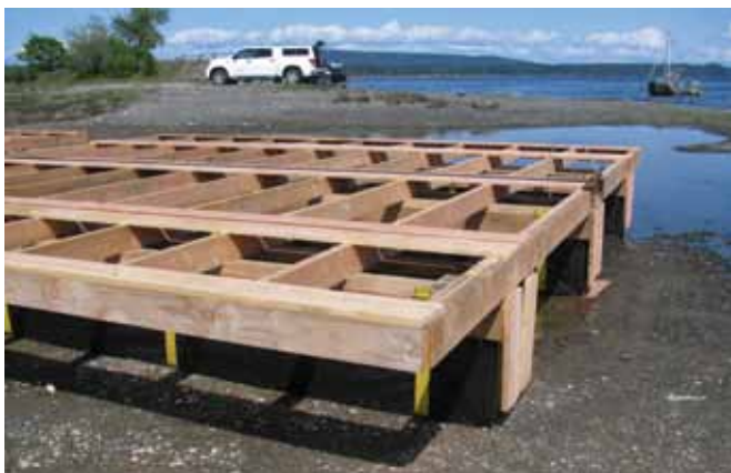
Figura 15. Balsa de cultivo construída em madeira e flutuadores de isopor forrados em lona encerada Foto: Felipe Matarazzo Suplicy
