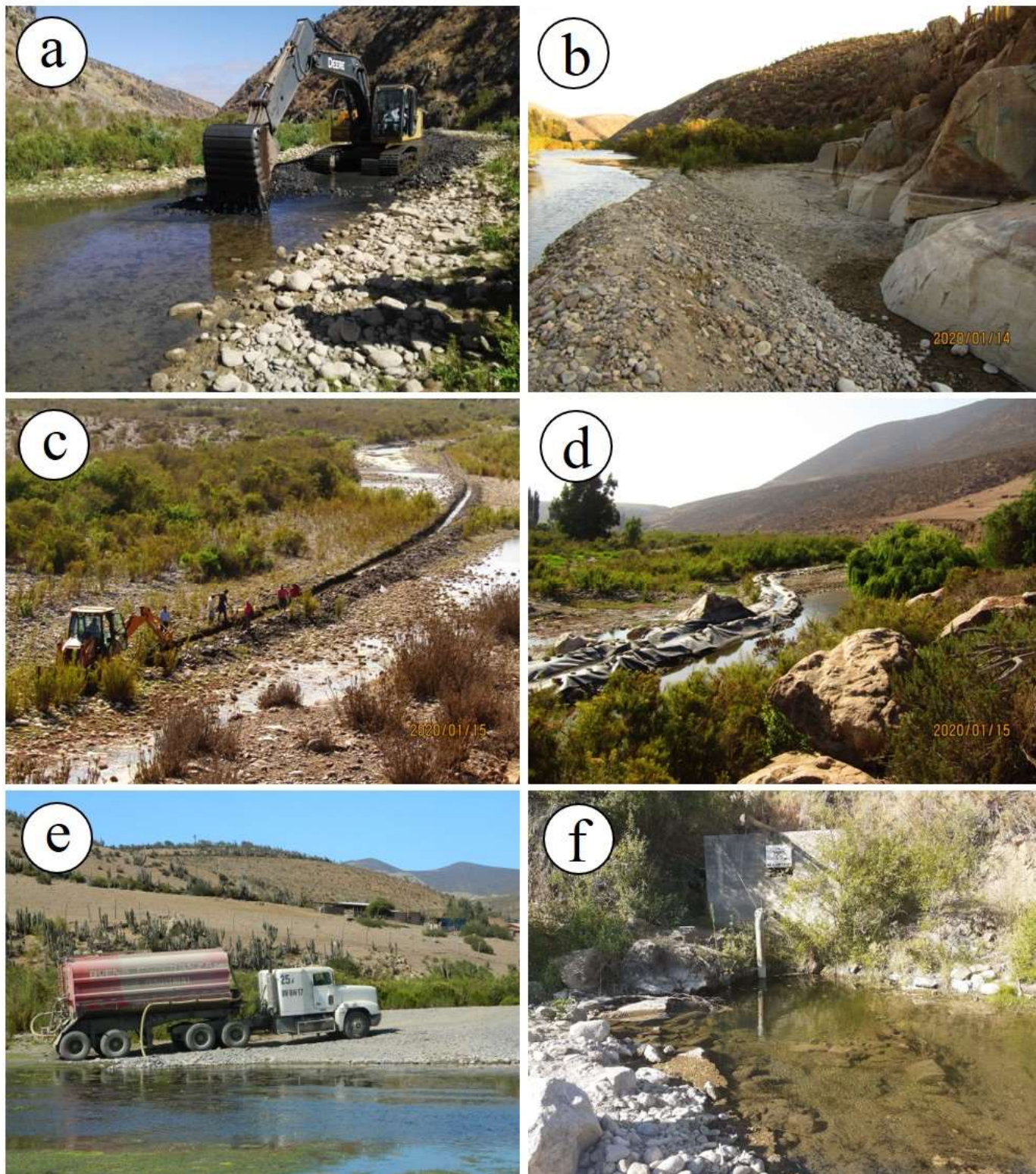
Figura 26. Perturbaciones antropogénicas directas sobre el habitat fluvial de Cryphiops caementarius en el río Choapa. (a) canalización del tramo fluvial utilizando maquinaria pesada, (b) tramo fluvial canalizado, (c) instalación de geomembranas utilizando maquinaria pesada, (d) tramo fluvial con geomembrana instalada, (e) extracción de agua para consumo humano, utilizando camión aljibe (f) bomba extracción de agua para riego de cultivo de paltos.
