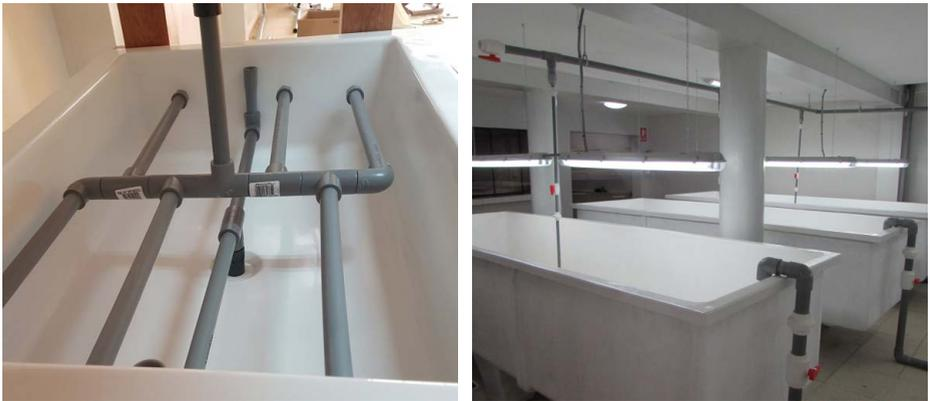
**Figura 16.** *Blower* (arriba) y sistemas de distribución de la aireación con tubos de PVC perforados (abajo), en los distintos estanques de cultivo.
