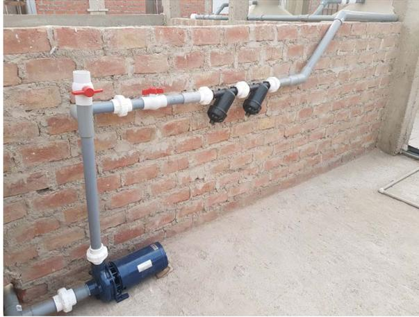
**Figura 14.** Sistema de bombeo de agua y filtro
