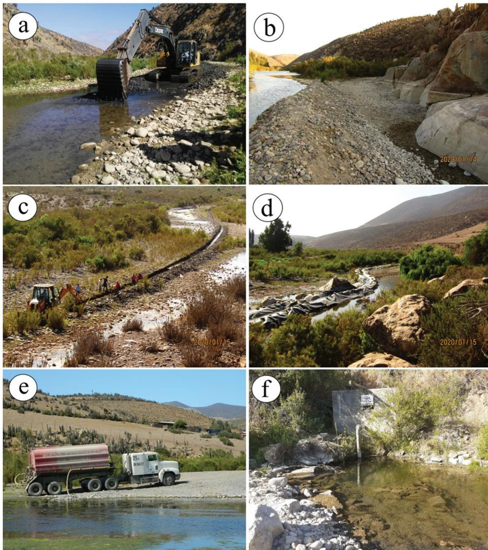
**Figure 4.** Perturbaciones antropogénicas directas sobre el hábitat fluvial de *C. caementarius* en el Río Choapa. (a) canalización del tramo fluvial utilizando maquinaria pesada, (b) tramo fluvial canalizado, (c) instalación de geomembranas utilizando maquinaria pesada, (d) tramo fluvial con geomembrana instalada, (e) extracción de agua para consumo humano, utilizando camión aljibe (f) bomba extracción de agua para riego de cultivo de paltos.
